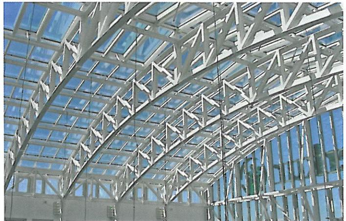
Durch die energetische Sanierung des Glasdaches wurde ein nach dem Bauteilverfahren für Glasdächer geforderter U-Wert von  $<2,00 \text{ W/m}^2\text{K}$  erreicht.
