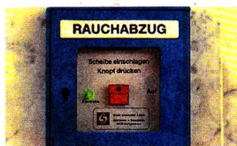
Manuelle Auslöseeinheit für eine Rauchabzugsanlage.
